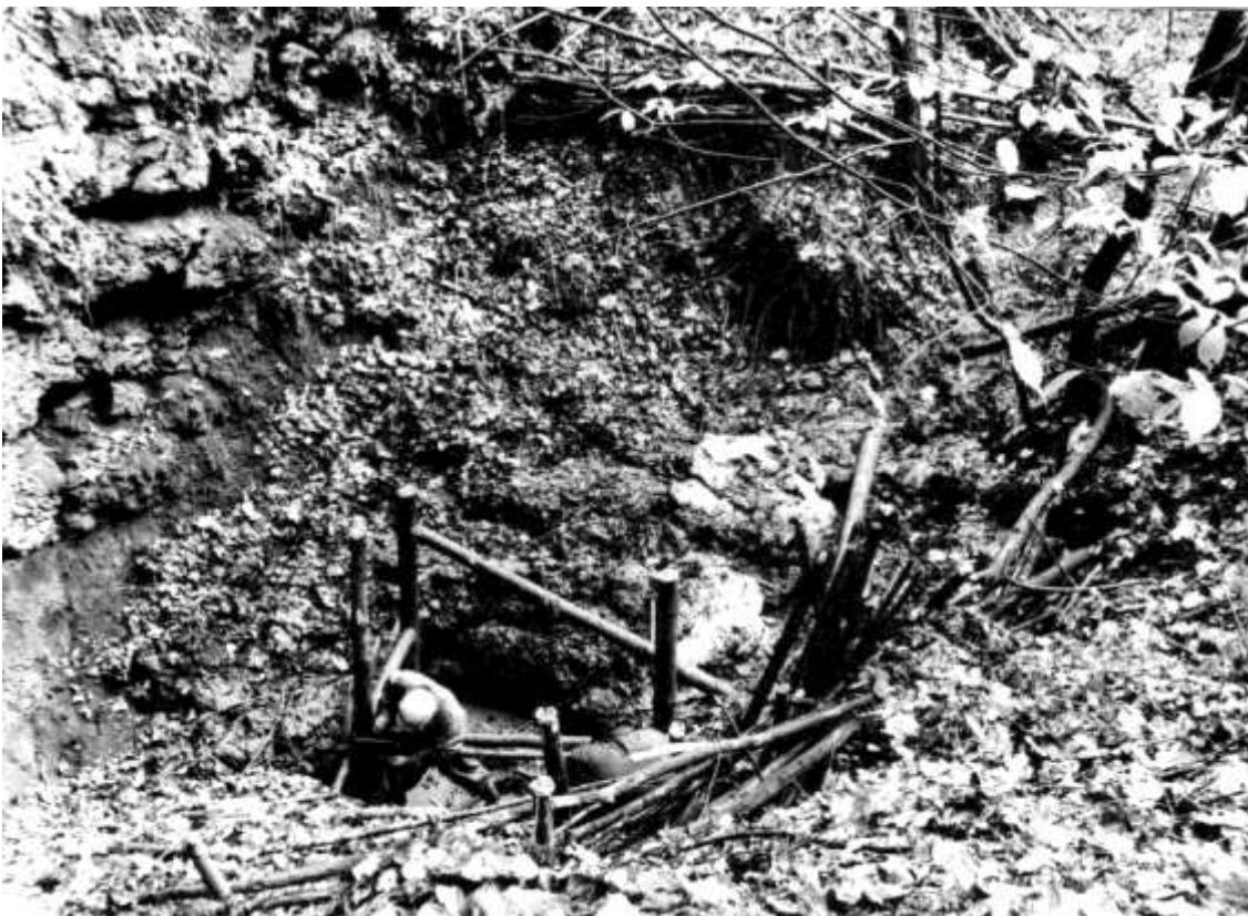
Beginn der Ausbauarbeiten im Sauloch bei Urbach (Foto: Michael Kabus)
