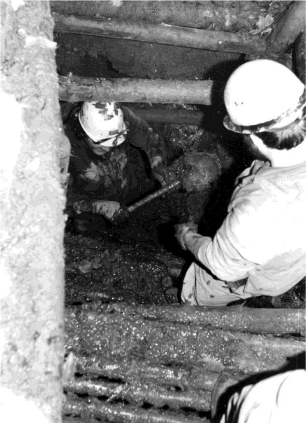
Während der Ausschachtungsarbeiten beim Vorstoß in die Tiefe (Foto: Michael Kabus)
