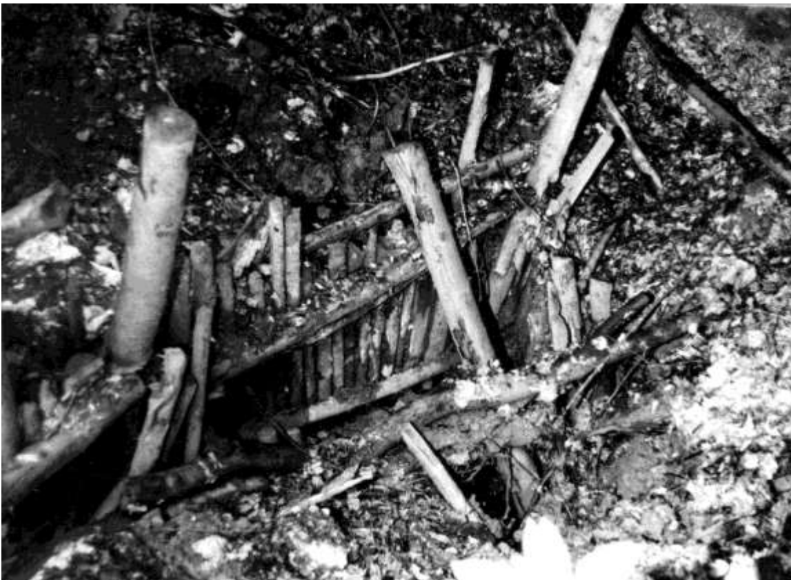
Der zusammengedrückte Holzausbau nach dem regenreichen Frühjahr 1981 (Foto: Michael Kabus)
