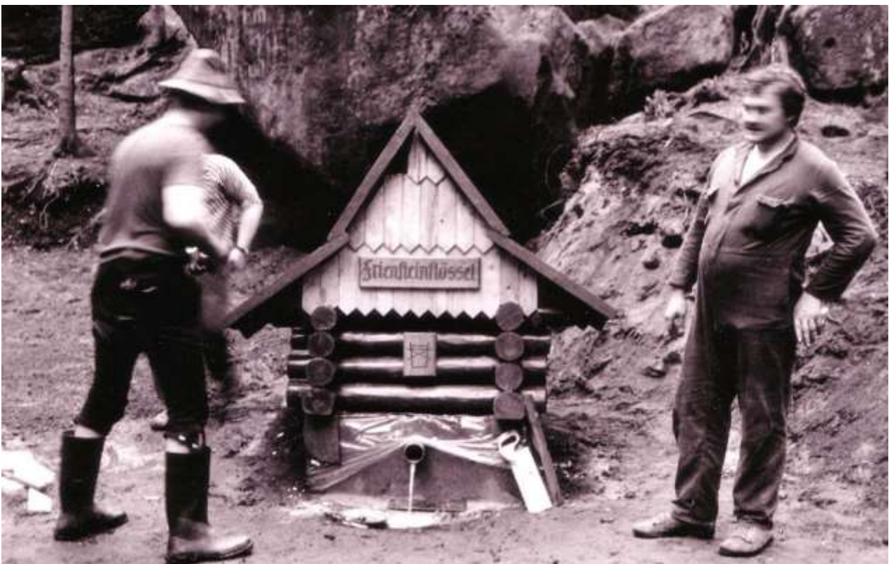
Am Frienstein (Sächsische Schweiz). Die Quellfassung ist fast fertig – das Wasser fließt schon.
