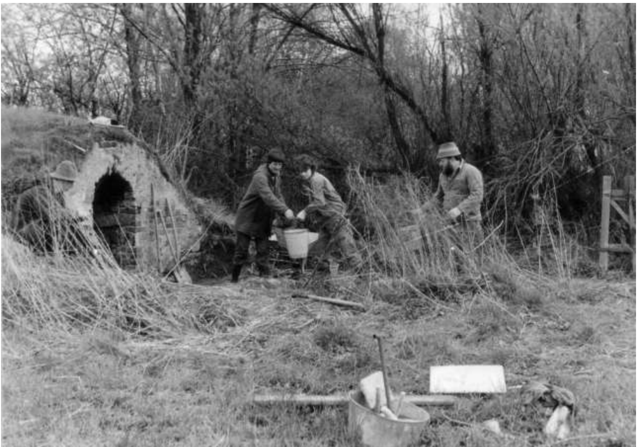
Erhaltungsarbeiten am Tonneborn bei Wurzen (Foto: Martina Pflaum)
