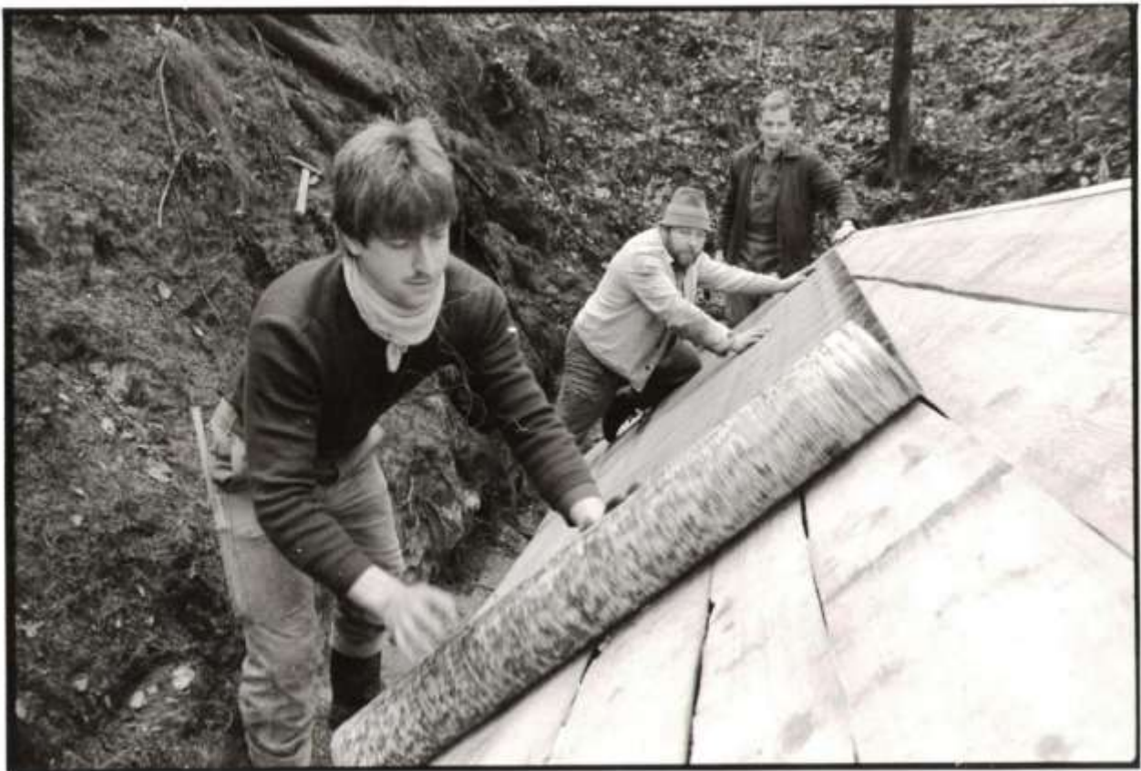
Die Abdeckung des Franzosenborn wird fertiggestellt (Foto: Rainer Hempel)
