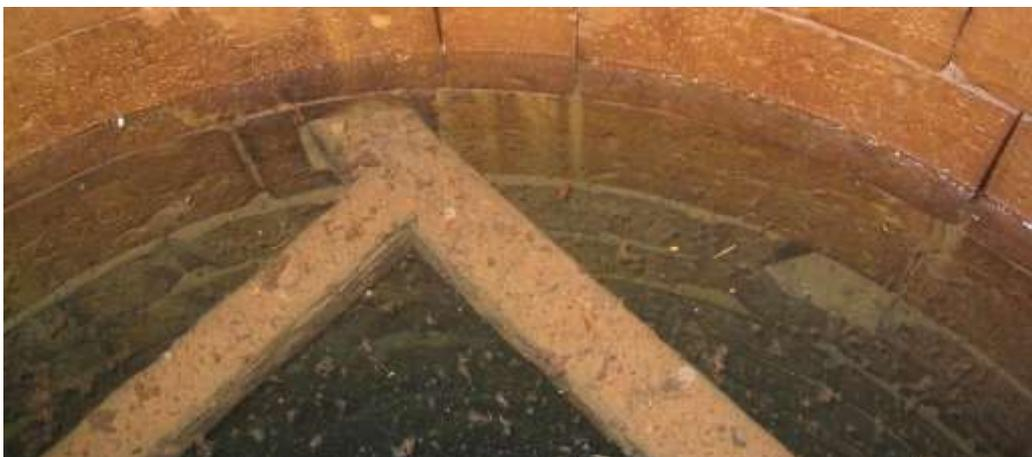
Balkenlager mit Resten einer Arbeitsbühne kurz unter der Wasseroberfläche
