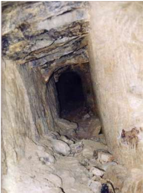
Der Stollen durchfährt einen stark verwitterten Basitgang und ist hier teilweise ver-
