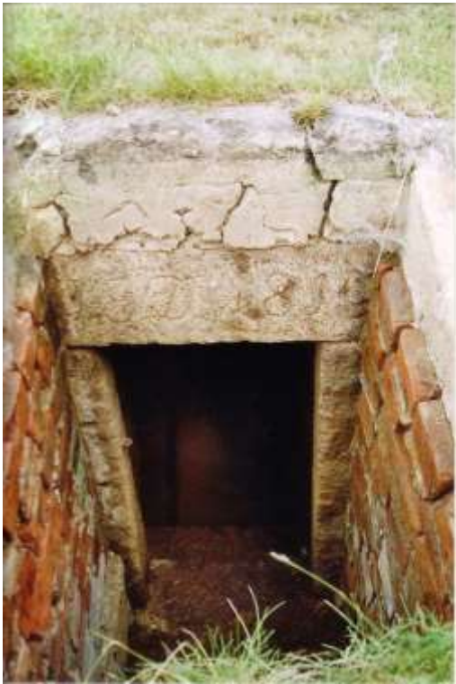
Mundloch des Wasserstollens mit den Initialen JGD 1818
