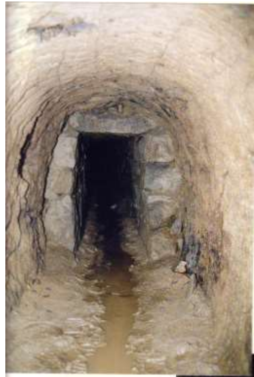
Übergang vom Stollen in ehemals offener Bauweise in den anstehenden Granodiorit
