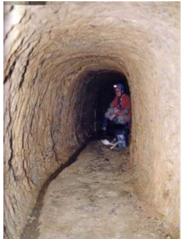
Exakt ausgeschlägelter Stollenabschnitt mit Gerinne zur Ableitung des Bergwassers
