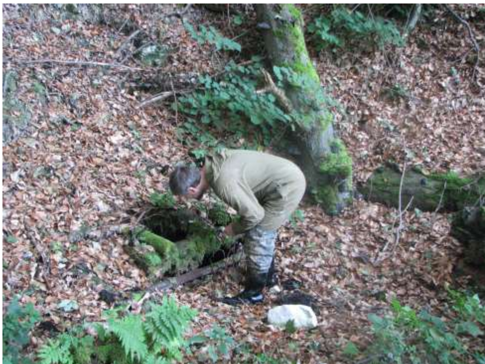
Teilweise beginnt die alte Abdeckung des Glücksritterschachtes bereits einzubrechen, ein Betreten kann mit einem unkontrollierten Abgang in die Tiefe enden.
