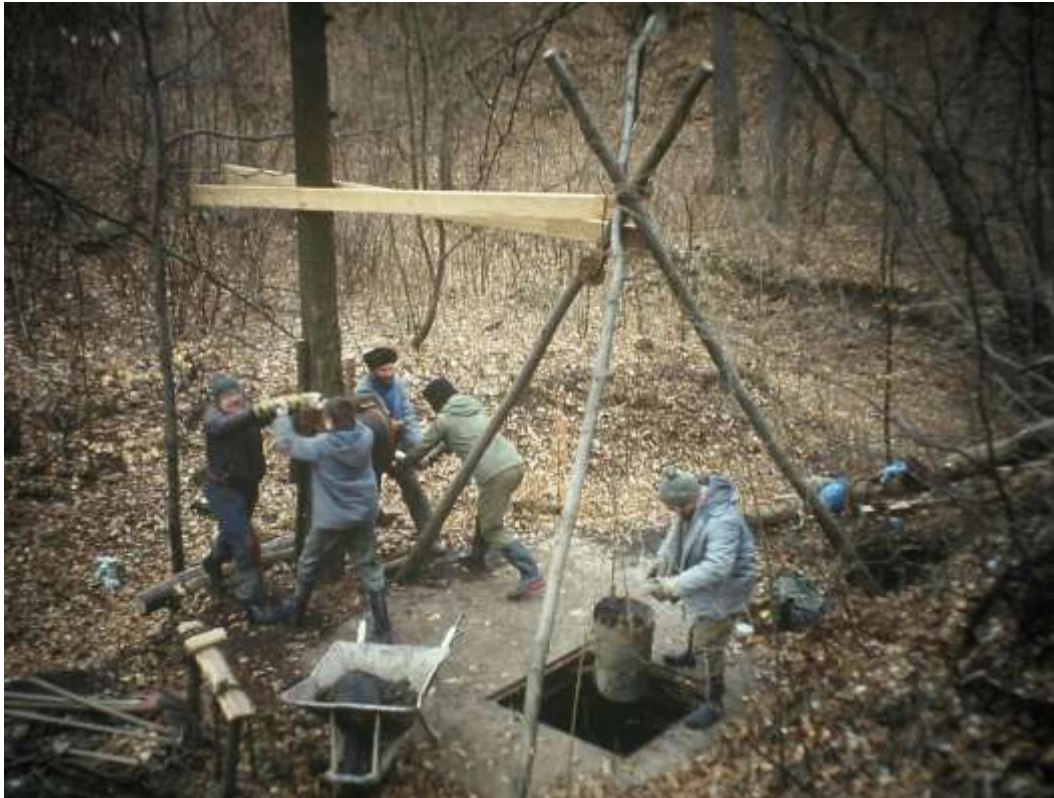
Die bewährte Eigenbauwinde von Andreas Ludwig kann von 4 Leuten bedient werden und damit ist sie die ideale, stromunabhängige Fördereinrichtung für Mensch und Material. Bei vielen Projekten war sie bereits eine unentbehrliche Hilfe
